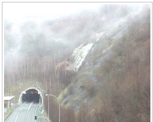
Vista general del túnel de Almandotz.
