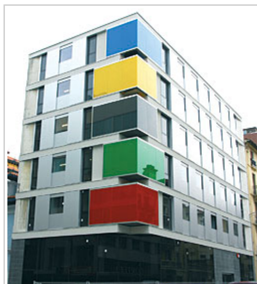
La Casa del Deporte, sede de las federaciones navarras.
