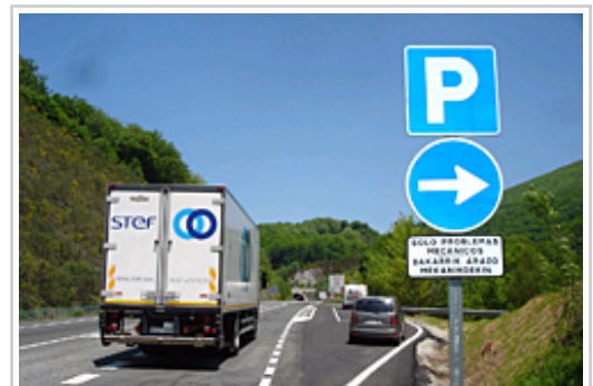
Vista de la zona de parada para vehículos averiados habilitada en una de las bocas del túnel de Belate.
