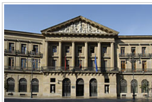
Fachada del Palacio de Navarra.
