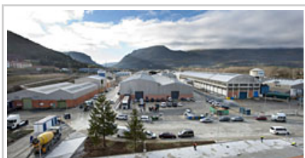
Vista de la reurbanización de la antigua Inasa.
