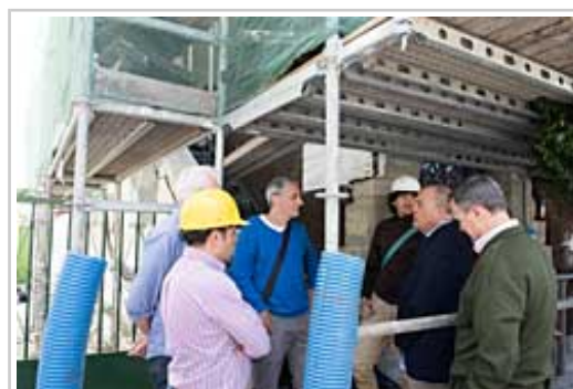
El consejero Zarraluqui visita obras de instalación de envoltente térmica.
