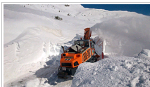
La turbofresadora durante los trabajos de limpieza de la carretera del Puerto de Belagua.
