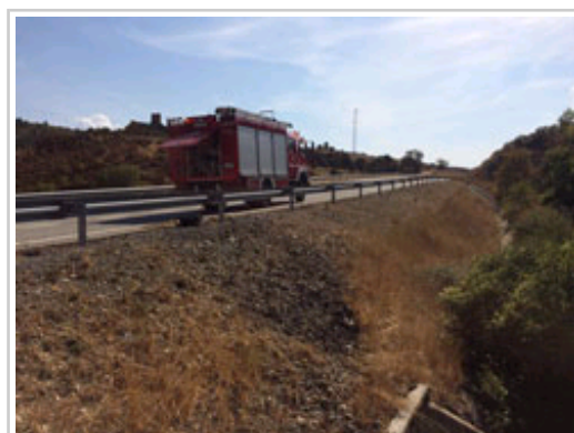
Lugar en el que se ha producido el conato de incendio.
