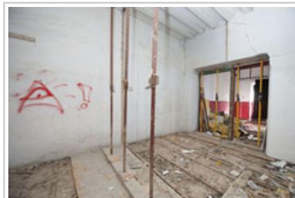
Espacio con el pavimento levantado.
