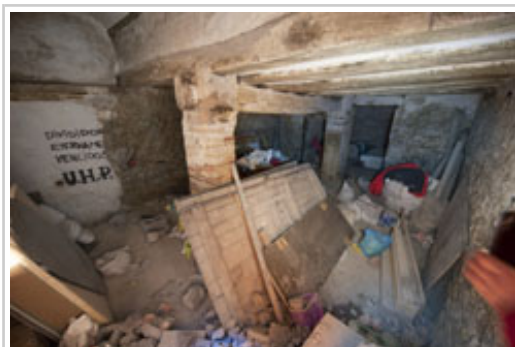
Acumulación de material de obra en una de las estancias.
