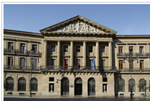
Fachada del Palacio de Navarra.
