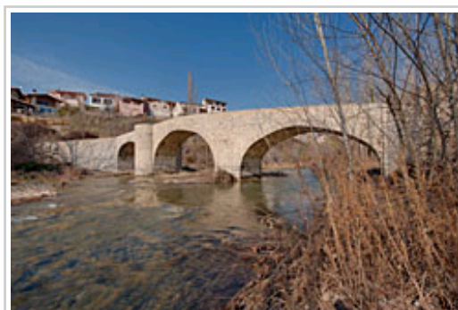
Puente de las Cabras de Lumbier, de Lumbier, recién restaurado.
