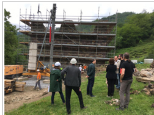
Visita a las obras de restauración.
