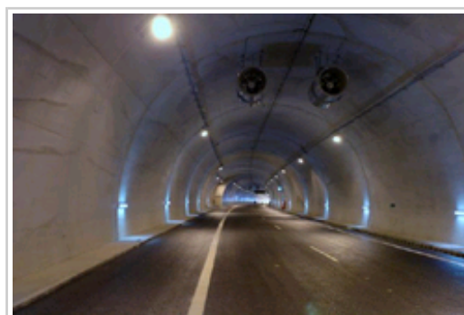
Imagen de un túnel.
