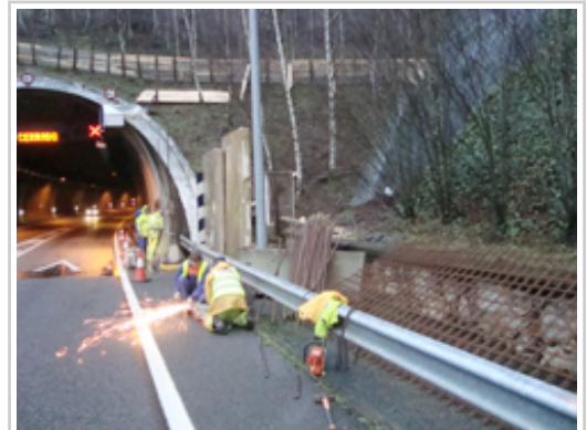
Personal trabajando en la instalación de barreras en el talud afectado.
