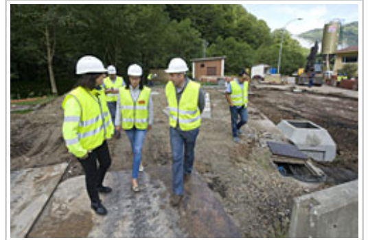
Obrarako bisita tunelen kanpoaldean.
