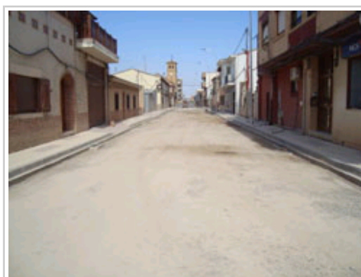
Imagen del tramo objeto de las actuaciones en la travesía de Ribaforada.
