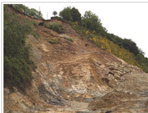
Barrera de contención de la masa arcillosa deslizada con piedra de escollera.
