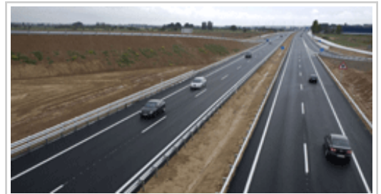
Autovía del Camino A-12.
