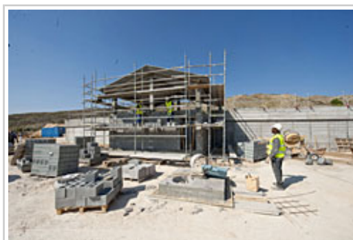
Depósito de agua de Andosilla en construcción.
