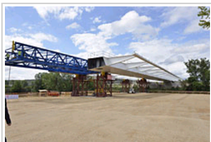
Construcción del puente sobre el río Ebro.
