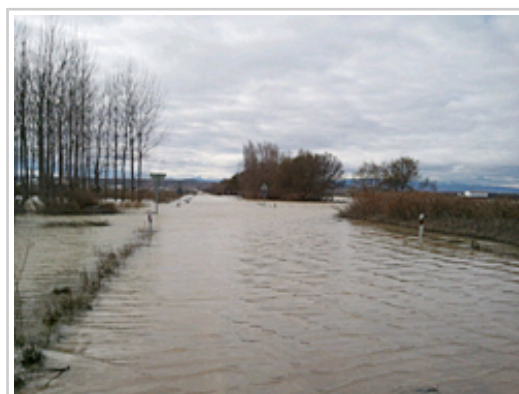
La carretera N-113 inundada por el desbordamiento del Ebro.
