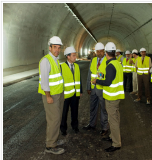
Egiten ari diren Jacako Autobiako tunelaren barruan, Amador Mariscal, obraren burua, Anai Astiz, Sustapen eta Etxebizitza kontseilaria, Alimamy P. Coroma, Sierra Leonako Obra Publikoen ministroa eta Naxaneko Eduardo Sanzol
