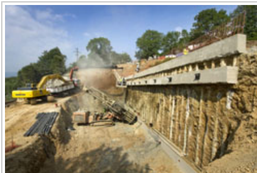
Tunelaren hegoaldeko hegala egonkortzeko mikropiloteen pantailaren irudia.
