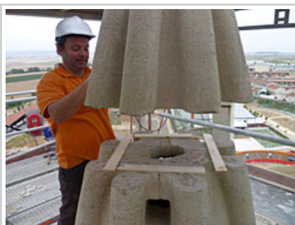
Un operario termina de colocar el tambor octogonal de la torre.
