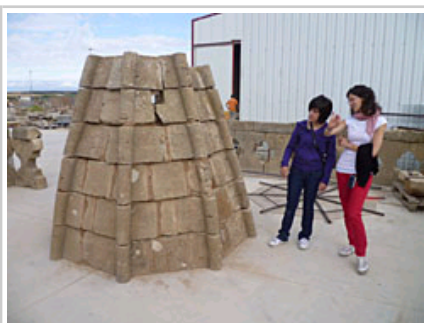
El tambor octogonal de la torre, desmontado para su restauración.
