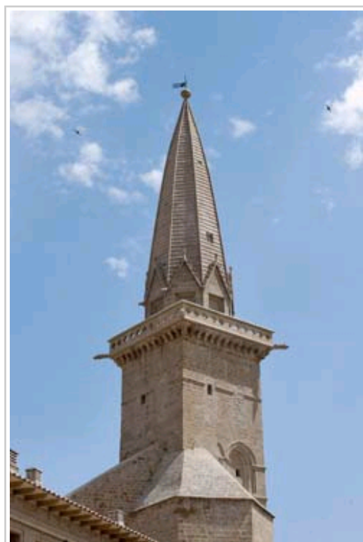
Vista de la torre restaurada.
