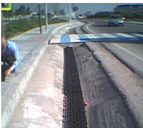
1. Extensión de celdas de drenaje
