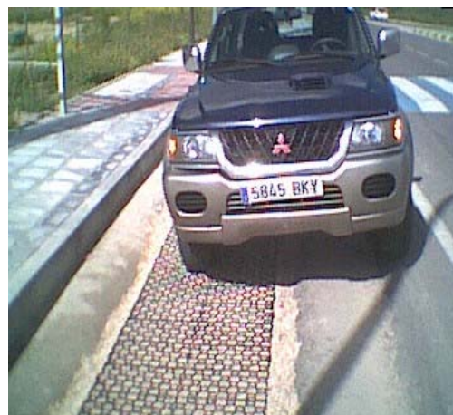
4. Gravilla estabilizada, transitable
