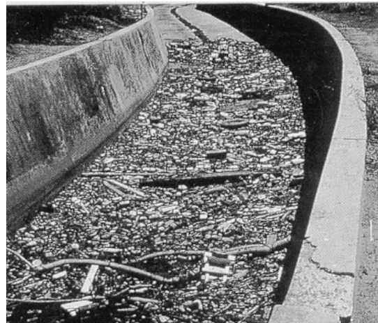
Fig. 2: Canal de hormigón: Sistema impermeable que Magnifica la contaminación del agua
