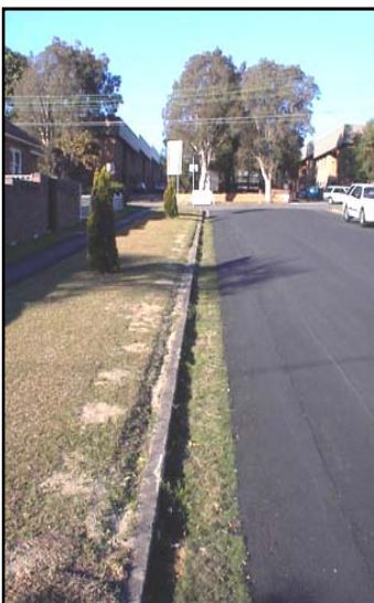
Fig.3 Sumideros permeables vegetados, gestión sostenible del agua de lluvia
