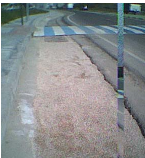
3. Relleno de gravilla
