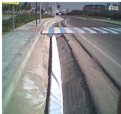
2. Envoltorio celdas con geotextil permeable
