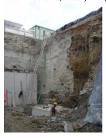
**Protección interior de zanjas.** La apertura de zanjas con medios mecánicos no presenta en general riesgos especiales en el momento de su apertura. No sucede lo mismo en las fases sucesivas de trabajo para la instalación de canalizaciones, aunque progresivamente, en función de la profundidad de la zanja, se van utilizando sistemas mecánicos de contención de tierras.
