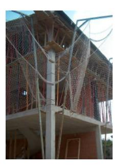
No obstante, se observan redes de horca que no cumplen los requisitos de la Norma UNE EN 1263-1 y 2, resultando su instalación dudosa desde el punto de vista de la eficacia protectora de la red. Otro aspecto a resaltar es el de la protección del trabajador en la fase de montaje e instalación de dichas redes; operación que se realiza con mucha frecuencia sin la utilización del arnés de seguridad por parte de los trabajadores que las instalan.
