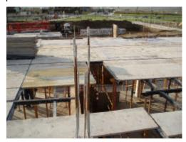
edificio. No se puede afirmar lo mismo en relación con protección perimetral de los encofrados en ejecución forjado de techo de planta baja, que normalmente se suelen realizar sin ningún medio de protección colectiva
