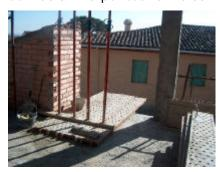
Las *plataformas voladas*, medios auxiliares utilizados para la recogida de materiales en los distintos niveles de la obra, generalment e disponen de protección lateral y frontal. Sin embargo, la recogida y retirada de materiales se realiza sin protección alguna. Este
