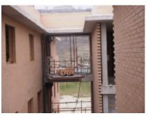
riesgo, puede ser evitable con la instalación previa de un anclaje al que se incorpore una línea de vida con arnés, que pueda ser utilizado por el trabajador en el momento de retirar la protección colectiva en la recogida de los materiales.
