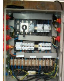
de cables sin clavijas y empalmes de cables mal ejecutados, que carecen del grado de protección que marca el REBT.
