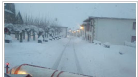
Labores de limpieza de la carretera en Aurtz-Burguete, posibilitando el acceso al centro de salud.
