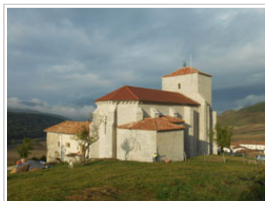
Imagen del templo una vez rehabilitado.
