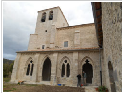
Fachada con pórtico posterior a la restauración
