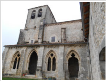
Fachada con pórtico previa a la restauración.
