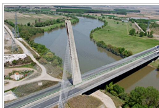
Imagen del puente de Castejón, en la Autopista de Navarra (AP-15).
