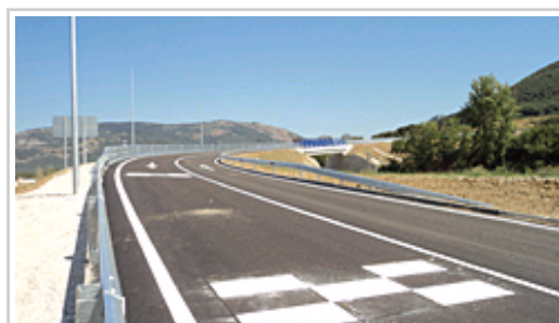
Imagen del nuevo paso. Al fondo la estructura sobre la vía.
