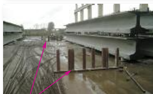
Peines para el acopio de vigas peraltadas
