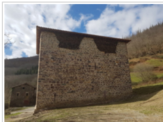
La torre restaurada.
