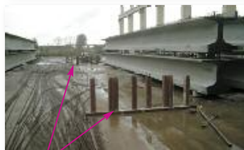
Peines para el acopio de vigas peraltadas
