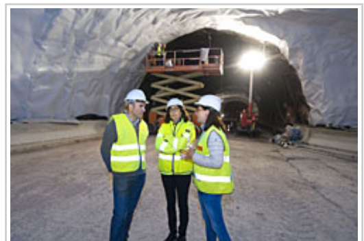
Manu Ayerdi atiende las explicaciones de Estela Moso, directora del Servicio de Construcción (Obras Públicas); Yolanda Fernández, jefa de Sección de Construcción de Nuevas Infraestructuras.
