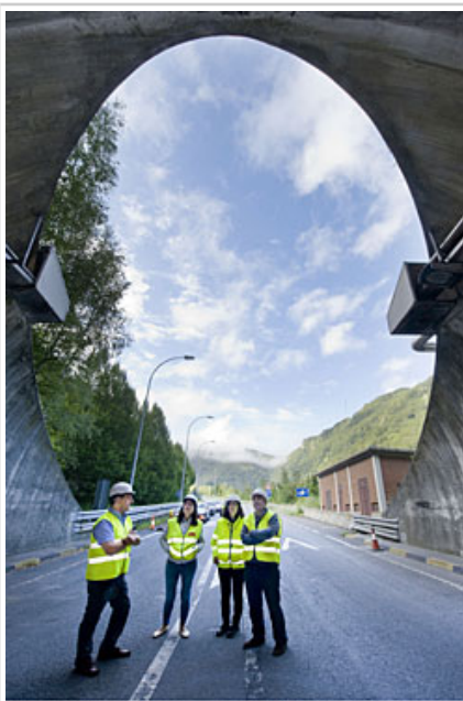
Perspectiva de una de las bóvedas de los túneles.
