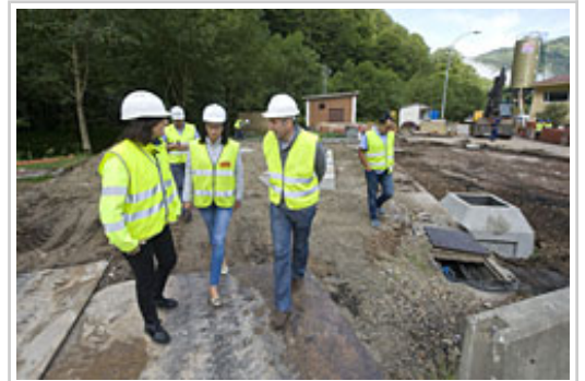
Visita a la obra en el exterior de los túneles.
