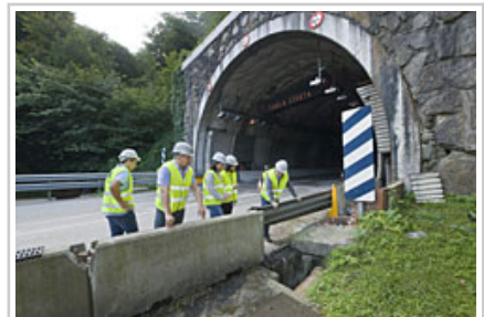
Revisión de una de las nuevas arquetas construidas.
