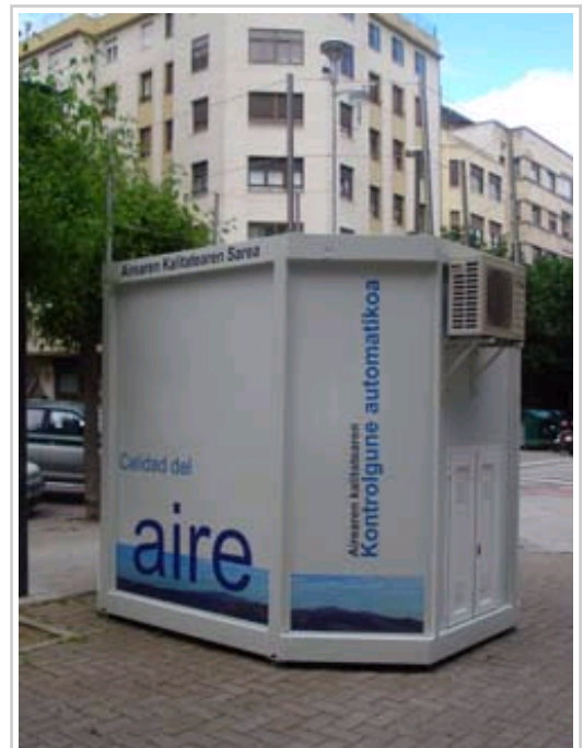
Estación de control del ozono en la plaza de la Cruz de Pamplona.
