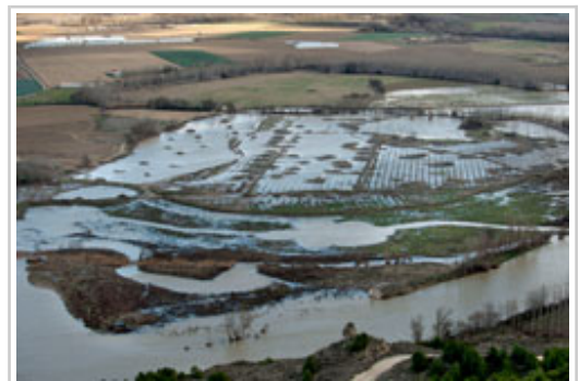
Campos inundados por el desbordamiento del Ebro.
