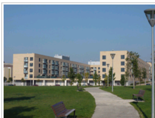
Eraikinak ebaluatze txostenak ikuskapen zorrotzak eskatzen ditu.
