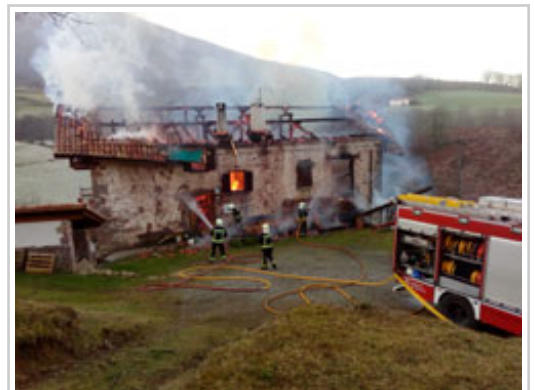
El caserío ha quedado completamente destruido por el fuego.
