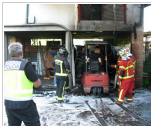
Tareas de limpieza en el centro transformador incendiado.
