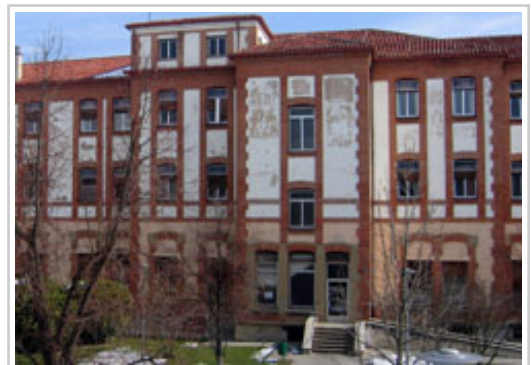
Pabellón C del Hospital de Navarra.
