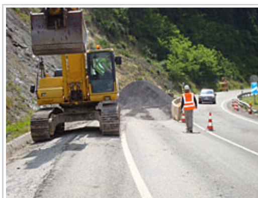
Trabajos de estabilización del talud, en Bera
