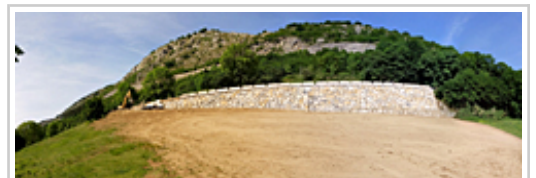
Nuevo muro de escollera.
