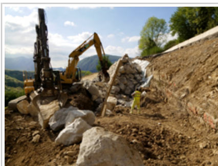
Imagen de los trabajos.
