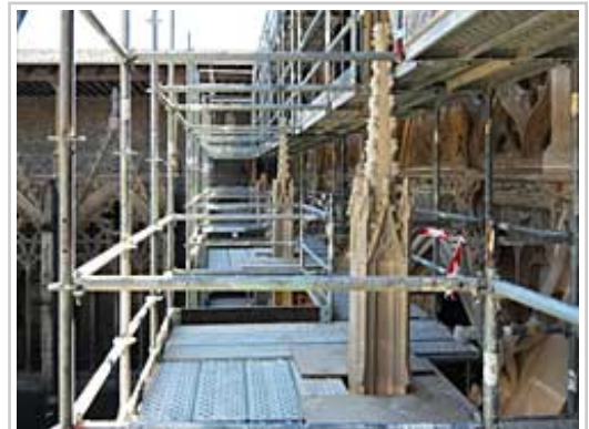
Imagen de las obras en la catedral de Pamplona.
