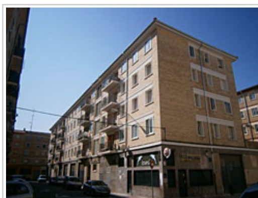
Viviendas de camineros en San Jorge.
