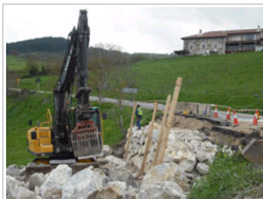
Imagen de las obras realizadas sobre la NA-4222 .
