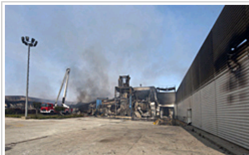
La nave de Tortillas Palacios ha quedado completamente calcinada.
