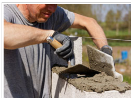
Una persona realiza trabajos de albañilería.
