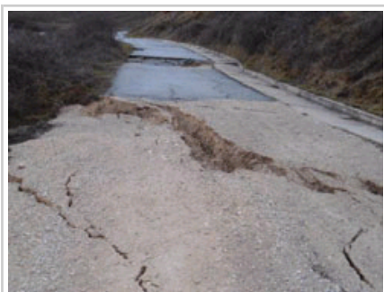
Carretera NA-5310, Ujué.
