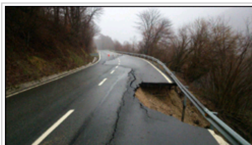
Imagen del hundimiento de la calzada ocurrido en la vía Pamplona-Francia por Valcarlos.
