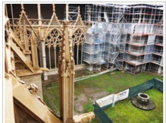
Restauración del claustro de la catedral de Pamplona.
