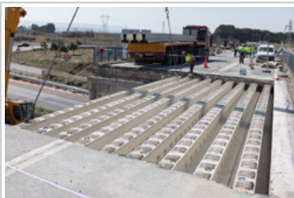
Las nuevas vigas ya colocadas.
