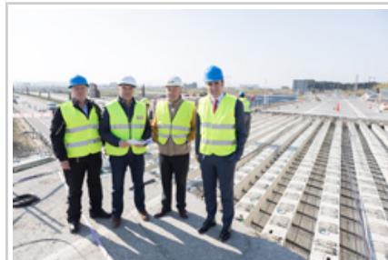
Manu Ayerdi junto a los responsables de la empresa que ejecuta la reparación.
